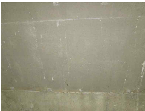
&lt; S1 바닥판하면 상태 양호 &gt;
