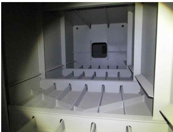
< 박스 내부 상태 양호 >
