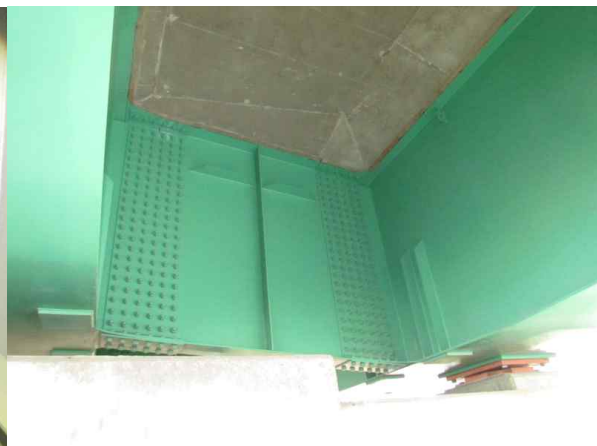
< 가로보 상태 양호 >
