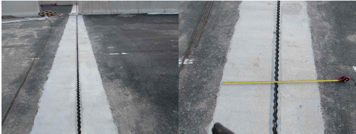
&lt; A2 신축이음장치 상태 양호 &gt;
