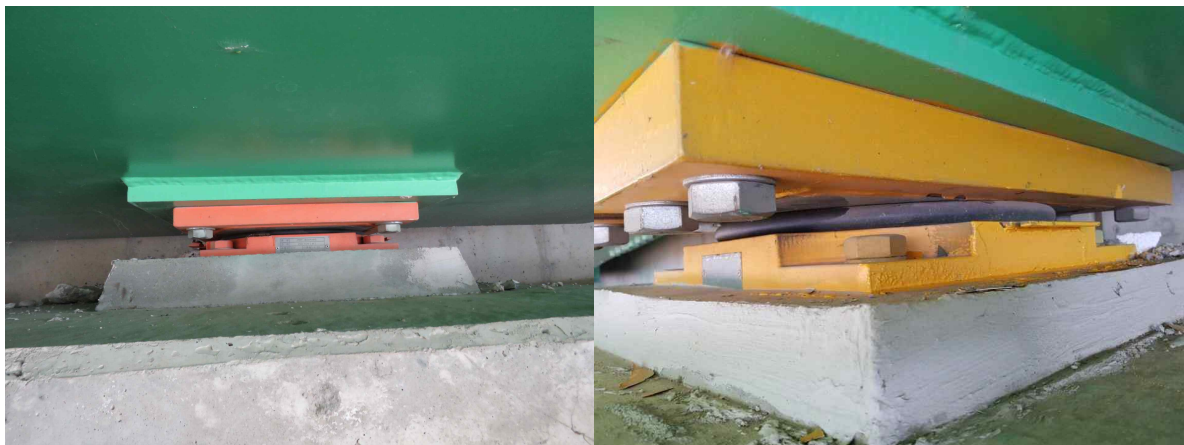
&lt; A2 받침몰탈 파손 보수 &gt;
