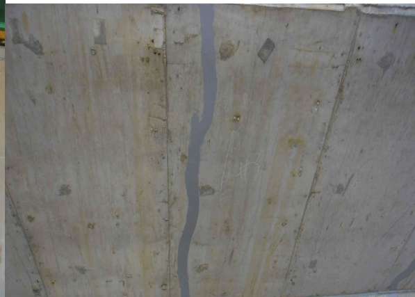
< 균열 보수 상태 >
