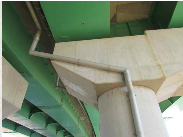
&lt; 배수관 시공 상태 &gt;
