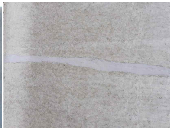
< 균열 보수 완료>
