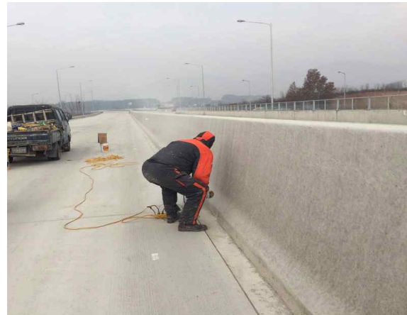
< 균열 및 백태 보수작업 광경>
