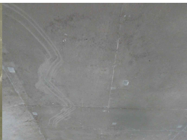
&lt; S2 바닥판하면 상태 양호 &gt;
