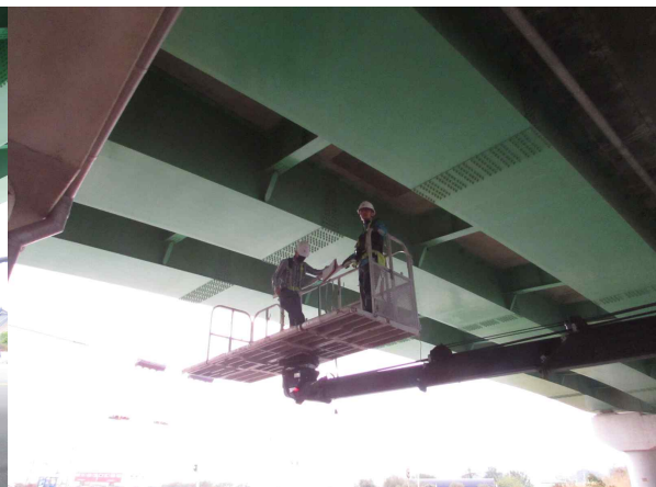
<점검차를 이용한 외관조사 현황>
